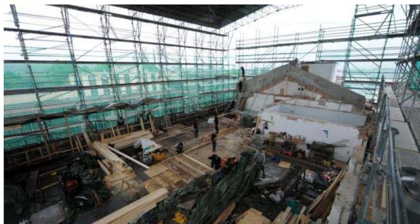
Blick unters Notdach der Alten Post: Dort sind Arbeiter gerade dabei, die Giebelwand mit einem Hut aus Stahlbeton zu stabilisieren.
